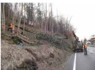
Interventi di sicurezza sulla S.S. 42
