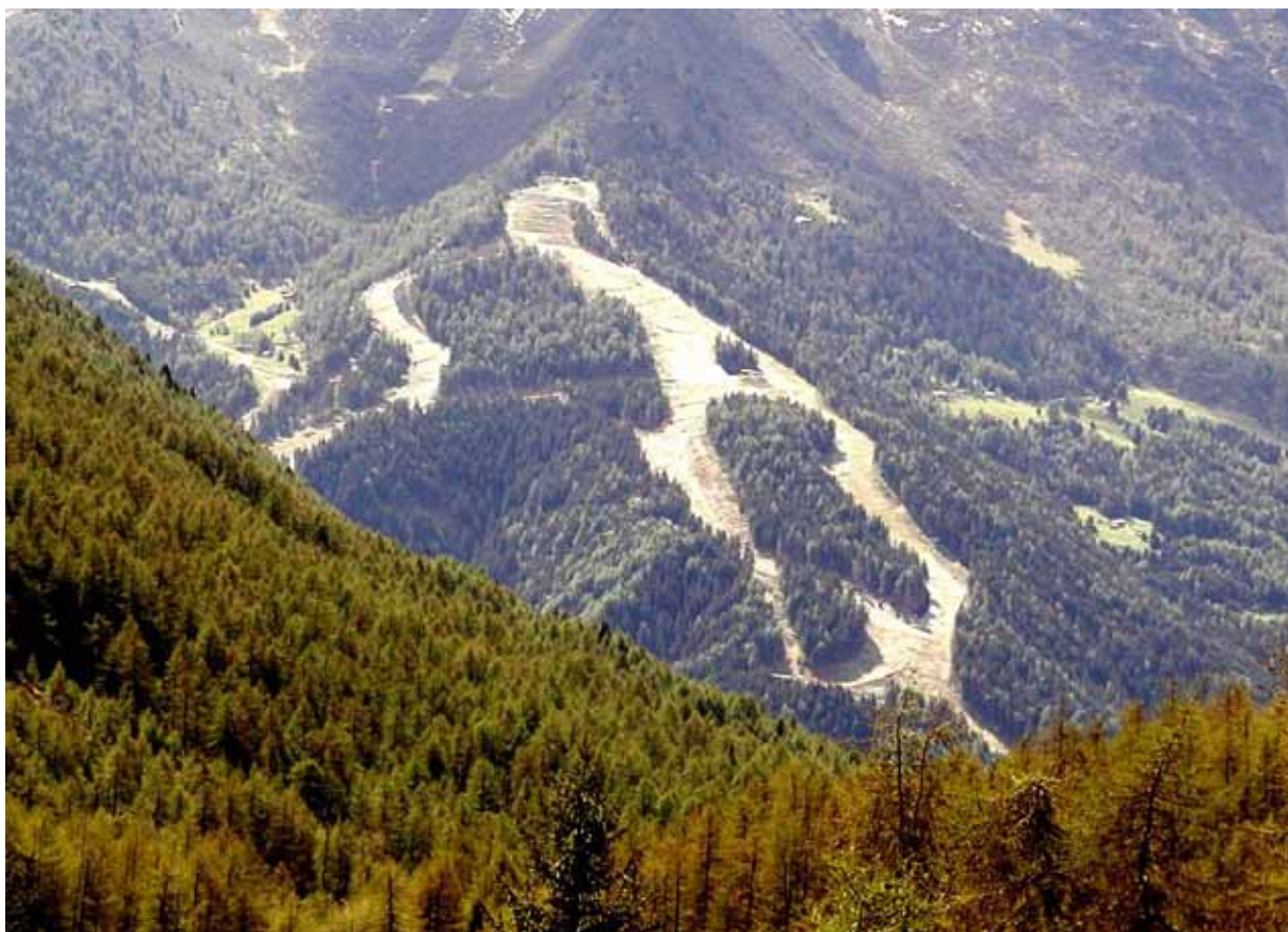
Il Comprensorio sciistico di Temù-Pontedilegno durante i lavori di realizzazione
